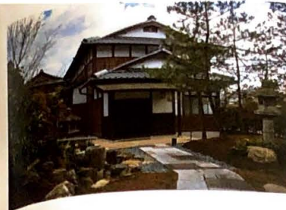
改修は庭づくりから
